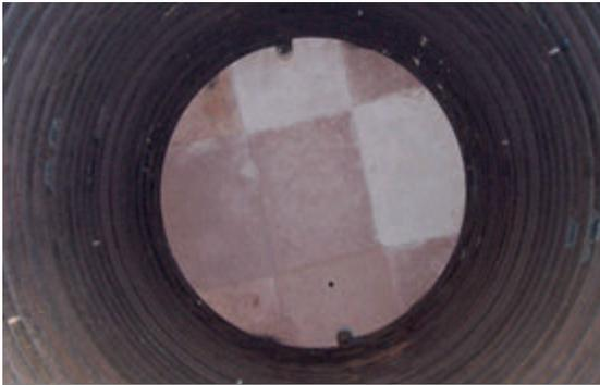
**Erhitzer-Rückwand mit Feuerleichtbeton**
