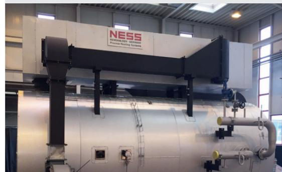
Erhitzer mit montiertem Verbrennungsluftvorwärmer
